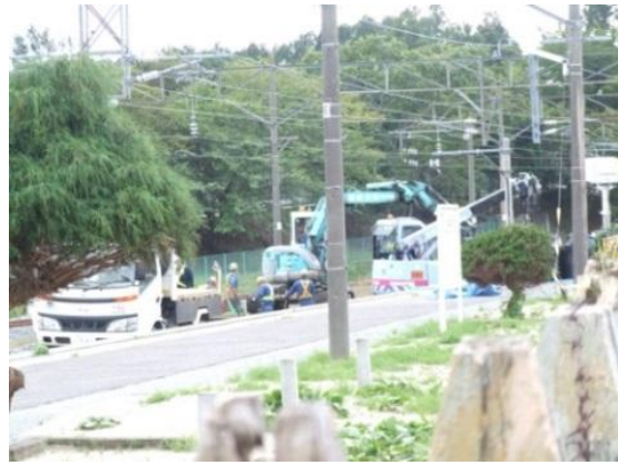
除染中の竜田駅構内
