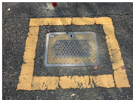
消火栓マンホール
