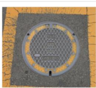
道路上の消火栓
