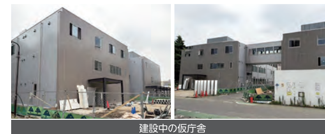
建設中の仮庁舎
